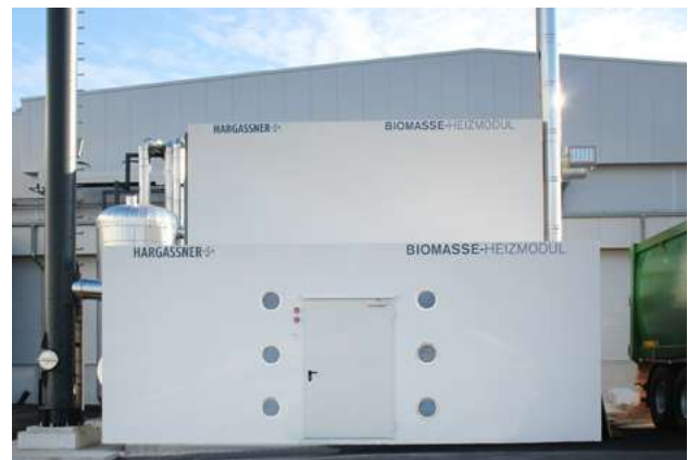
Mehrfach-Heizmodul 660 kW Hackgut, Industrie
